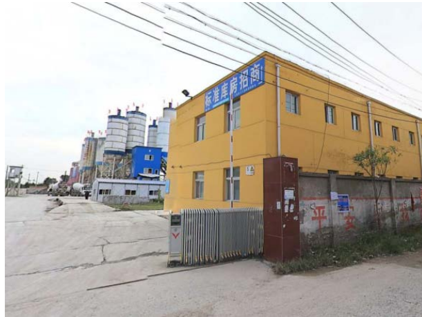
图3 现状北京诚泰混凝土制品有限公司
